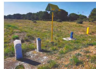
Figure 58 : Bornes indiquant la présence de canalisations de transport de fluides et gaz
