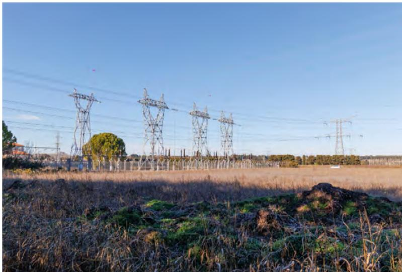
Figure 20 : Ligne aérienne à 400 000 double circuit REALTOR-TAVEL en sortie du poste de JONQUIÈRES (pylône type F44) et arrivées au poste (pylônes L1)
