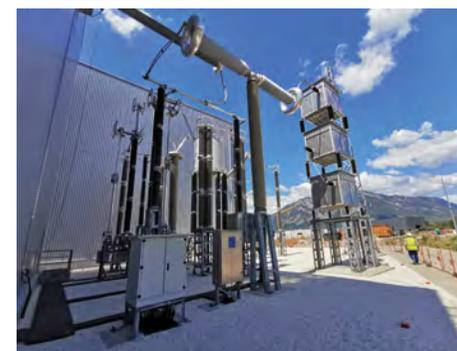
Figure 16 : Exemple de station de conversion 320 kV (intérieur et extérieur)
